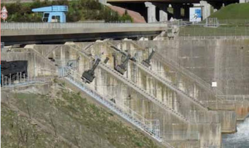
Le barrage de la Laye est situé sur la rivière de la Laye. D'une hauteur de 30 mètres, il est capable de retenir jusqu'à 3,3 millions de m<sup>3</sup> d'eau destinés principalement à l'irrigation de la région de Forcalquier. Il a été placé en révision spéciale pour insuffisance de capacité d'évacuation des crues.
