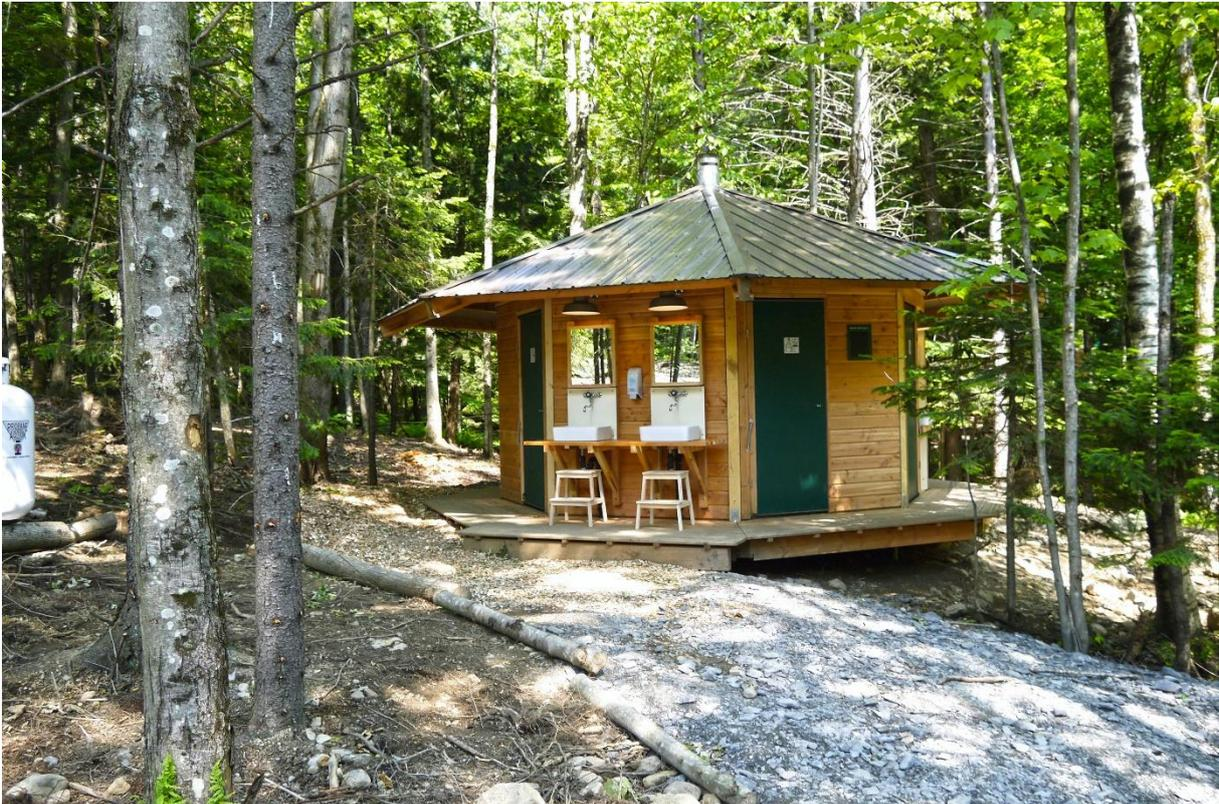
Il est prévu l'implantation de deux sanitaires dans la zone de projet. Il s'agit de modules octogonaux de 19,25 m<sup>2</sup> chacun, en structures bois, équipés chacun d'un chauffe-eau électrique.
